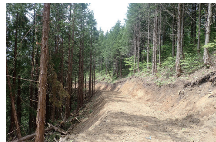
▲間伐のために新しく開設した作業道
